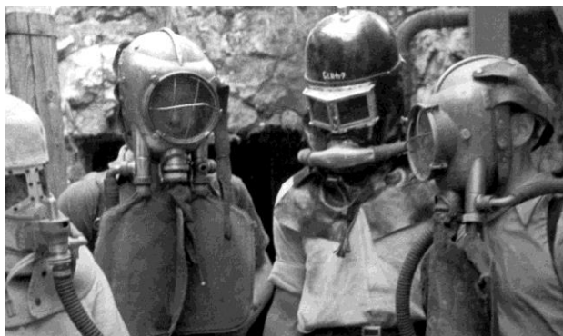
Fig. 1 - Palombari di miniera con rebreather ARO.
