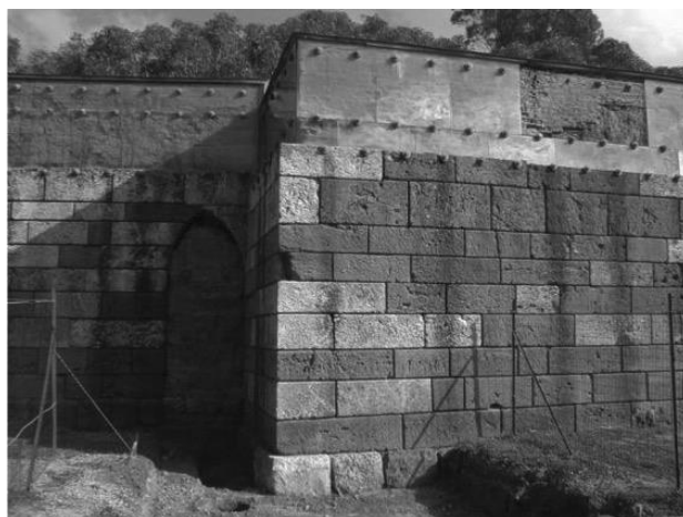
Fig. 8. - Gela. Lastre di vetro a protezione dei mattoni crudi.
