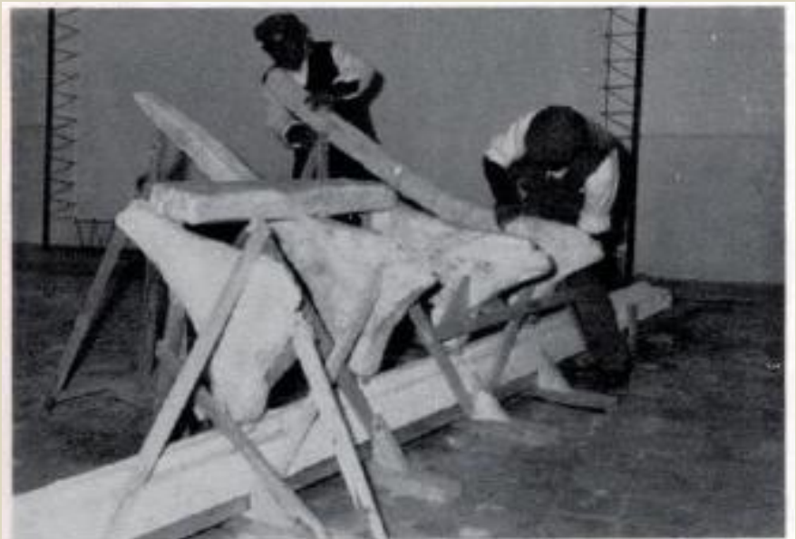
13 - MARSALA, BAGLIO ANSELMI: CALCO DI GESSO DELLE PARTI ARCHITETTONICAMENTE PIÙ SIGNIFICATIVE DELLA POPPA Eseguito nel 1975 prima che il legno venisse trattato, il calco resta a documentare un legname che non può essere esaminato tridimensionalmente dopo la ricostruzione. Qui, i carpentieri stanno preparando i calchi per una mostra del materiale di scavo nella scuola media del centro Pipitone di Marsala.
