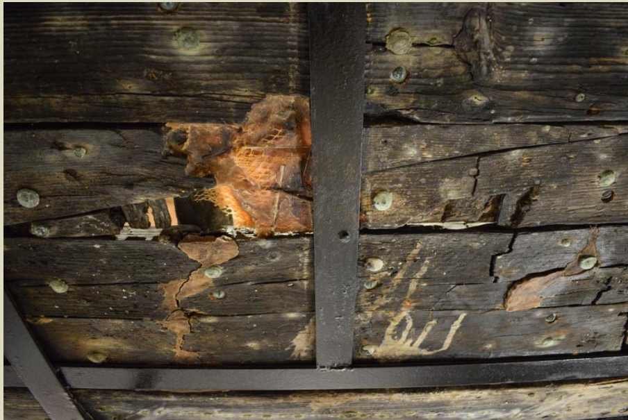
Integrazione lacuna con inserimento rete sintetica
