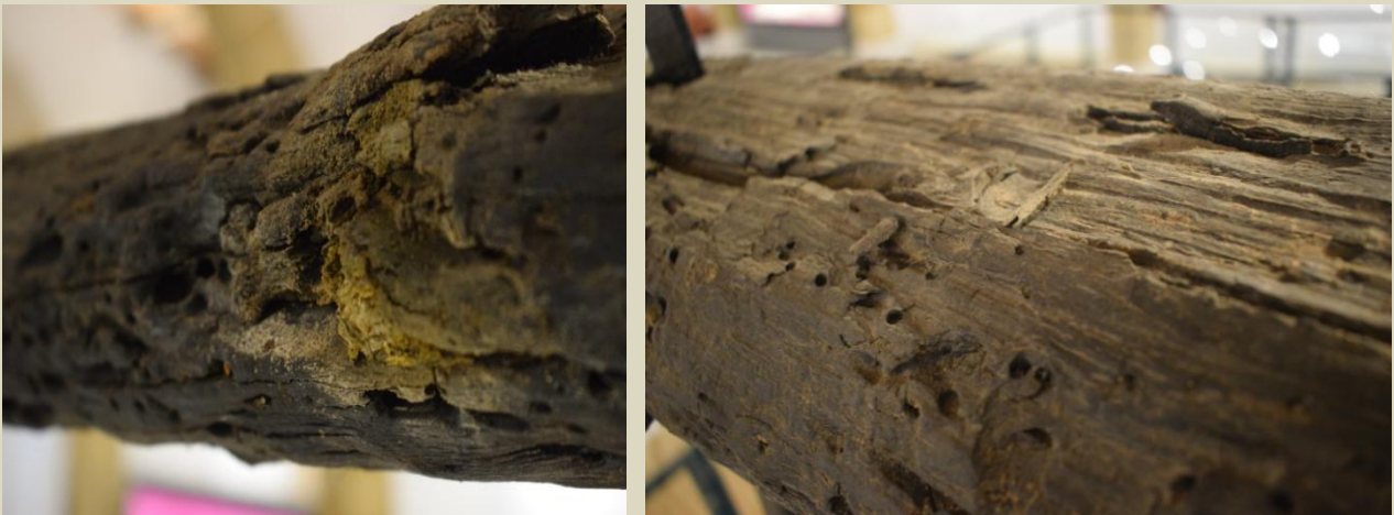
Fenomeno di degrado con morfologia circolare
