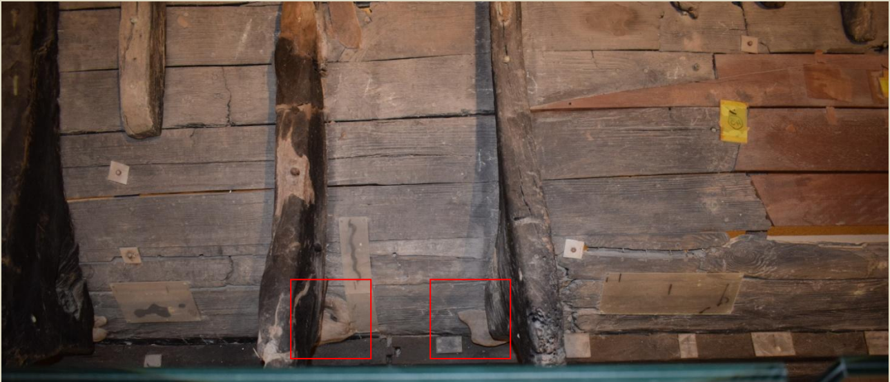
Zone di applicazione del mastice originario da parte dei costruttori
